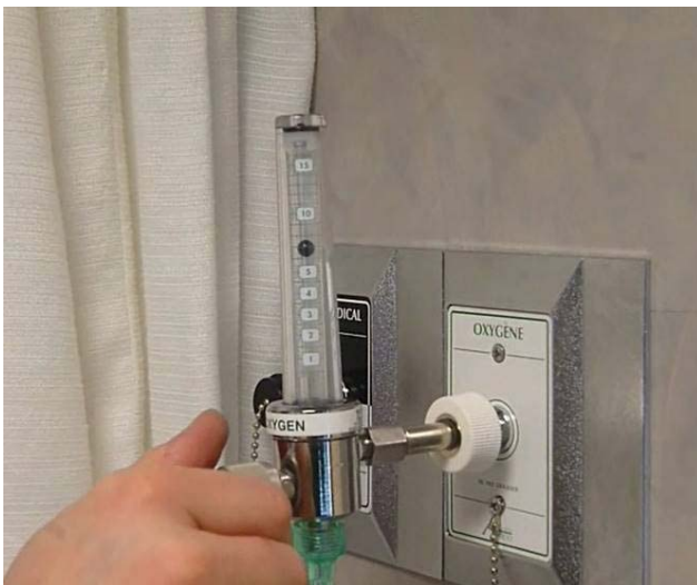
Débitmètre à oxygène conventionnel (réglage manuel) depuis 1910
