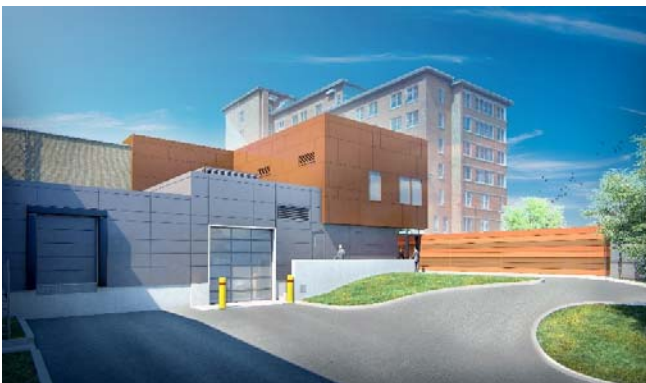
Visuel après la déconstruction
